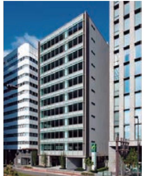
▲新大阪フロントビル
