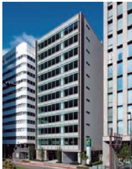
▲新大阪フロントビル
